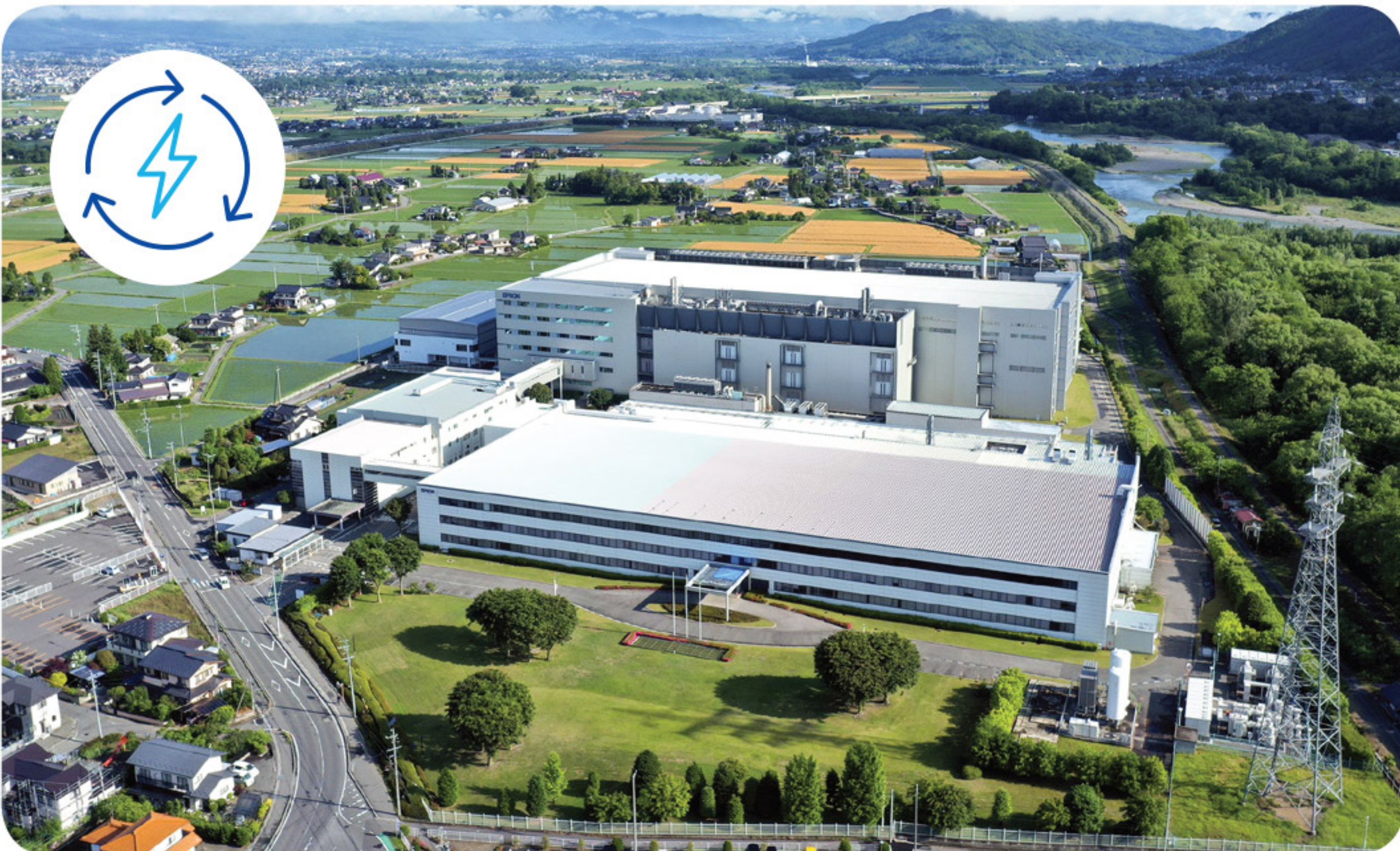
โรงไฟฟ้า Toyoshina ในประเทศญี่ปุ่น
